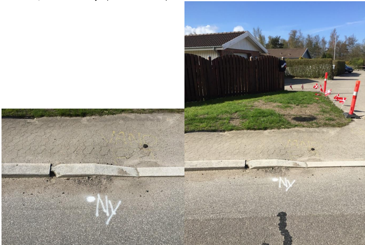
THORSVEJ, ud for Lokesvej 1 (1 sten udskiftes)
